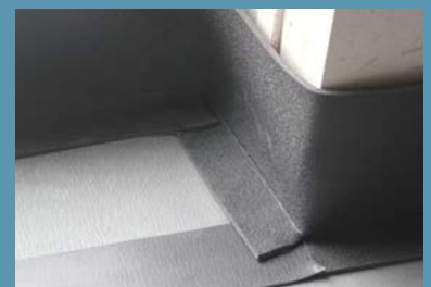
Verbinding tussen de muur en de insulit Bi+20 verwezenlijken met Lfoam 18 randstrook
