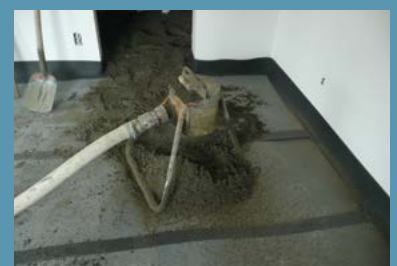
Versterkte chape gieten met een dikte van ±8 cm op insulit Bi+20
