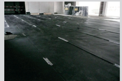
Het behoud van de overlapping verzekeren door bijgevoegde tape
