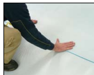
Een goede afdichting van de overlapping verzekeren
